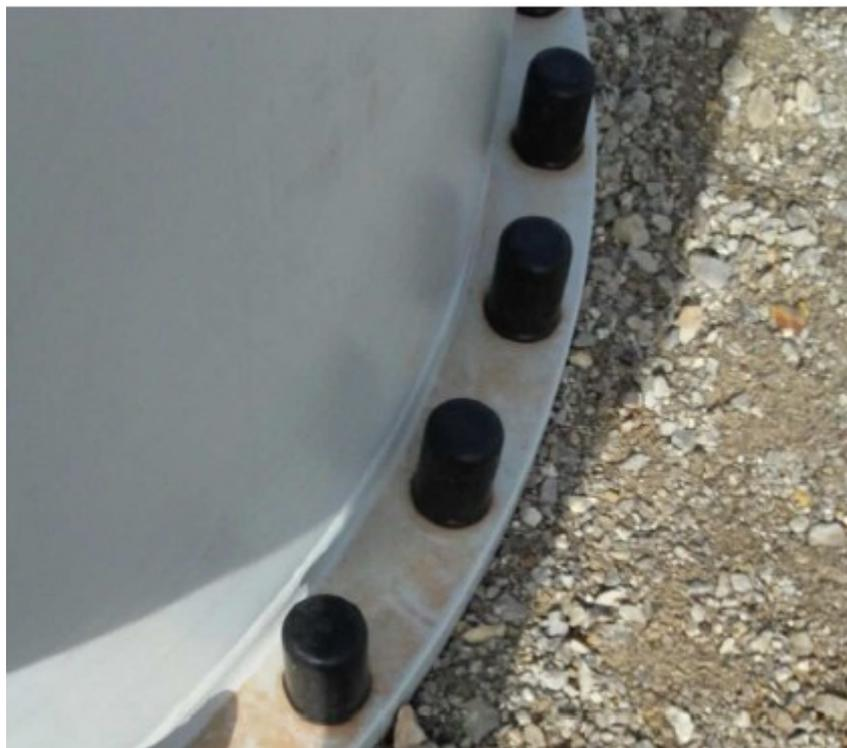
Fig. 6 – Particolare flangia di base, protezione della bulloneria
